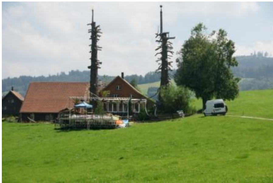
Abbau Tribüne – 22. August – Klangarena, Degersheim
