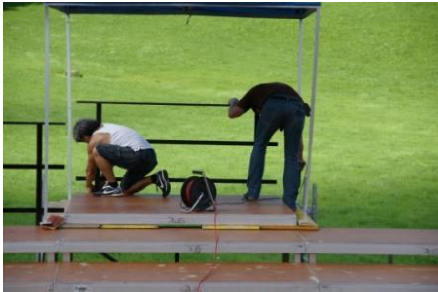
Abbau Tribüne – 22. August – Klangarena, Degersheim
